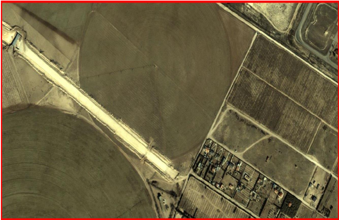
Figura 4.4. Estado de la explanación en obras de construcción de líneas de Alta Velocidad Ferroviaria.
